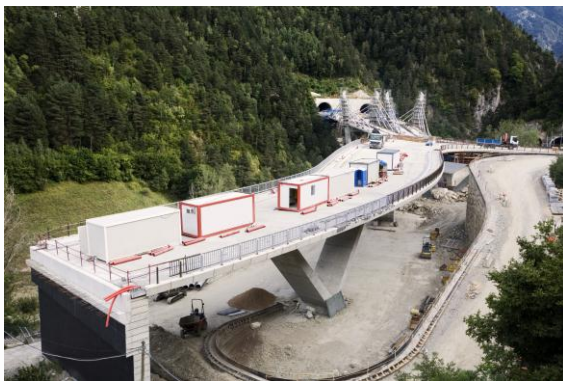
在 Andorra 建設中的高速公路橋樑及隧道
